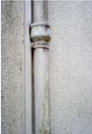
Conduit de fluide (eau) descente d'eau pluviales (1 u)
